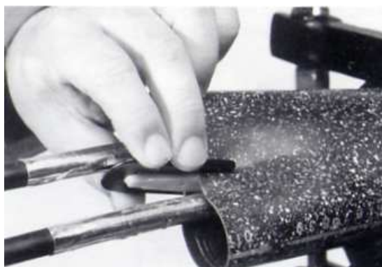
Σχήμα B2.3.15 Επανατοποθέτηση θερμοσυστελλόμενου σωλήνα και προσαρμογή τριχάλου.
