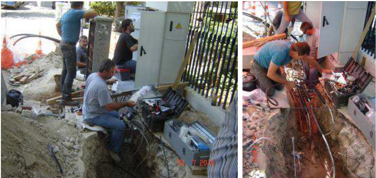
Σχήμα A9.2.21 Δικτυακές εργασίες μεταγωγής των συνδρομητών από το KV στον κατανεμητή της καμπίνας Γ3.
