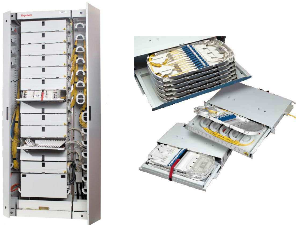
Σχήμα B2.4.1 Ενδεικτικός κατανεμητής τύπου Α – Ικριώμα, ράφια και ένθετα πλαίσια τερματισμού και διασύνδεσης
