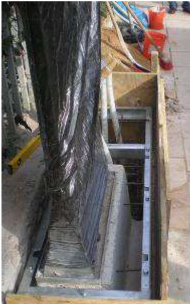
Σχήμα A9.2.9 Τοποθέτηση ξυλοτύπου, σκυροδέτηση και επανατοποθέτηση μανδύα KV
