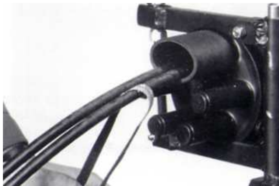
Σχήμα B2.3.12 Προετοιμασία επιφανειών οβάλ εισόδου και καλωδίων για τοποθέτηση του θερμοσυστελλόμενου σωλήνα
