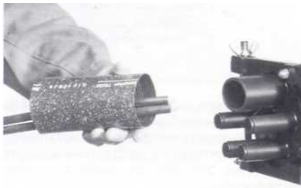
Σχήμα B2.3.4 Τοποθέτηση θερμοσυστελλόμενου σωλήνα
