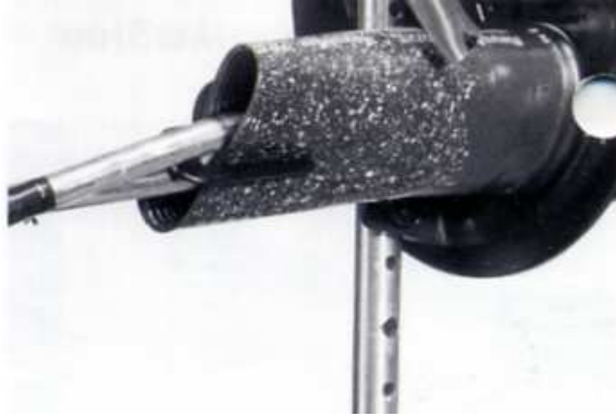
Σχήμα B2.3.16 Θέρμανση θερμοσυστελλόμενου σωλήνα
