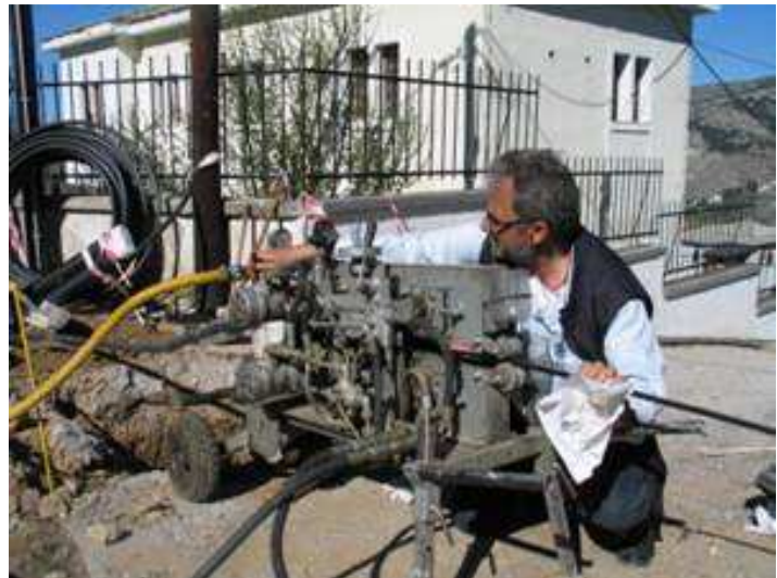
Σχήμα Β2.2.1 Τεχνική τοποθέτησης ΚΟΙ σε σωλήνωση με την μέθοδο της εμφύσησης
