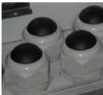
Σχήμα A.9.3.7 Στυπιοθλίπτες στο εσωτερικό καμπίνας
