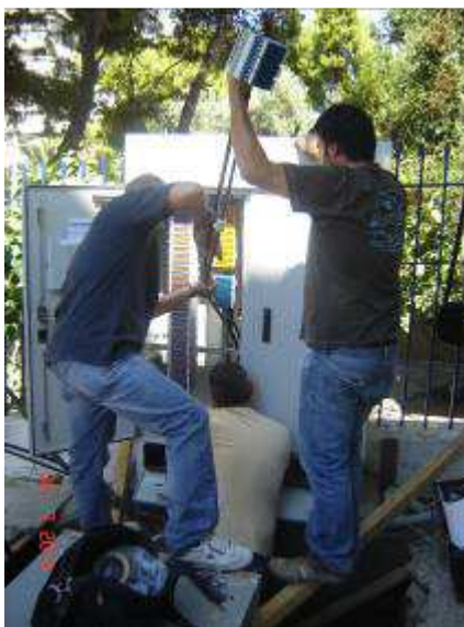
Σχήμα A9.2.19 Τοποθέτηση του κατανεμητή καλωδίων χαλκού στην καμπίνα Γ3 κατά και μετά την ολοκλήρωση των εργασιών τοποθέτησης
