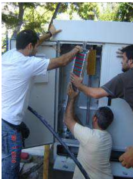
Σχήμα A9.2.19 Τοποθέτηση του κατανεμητή καλωδίων χαλκού στην καμπίνα Γ3 κατά και μετά την ολοκλήρωση των εργασιών τοποθέτησης
