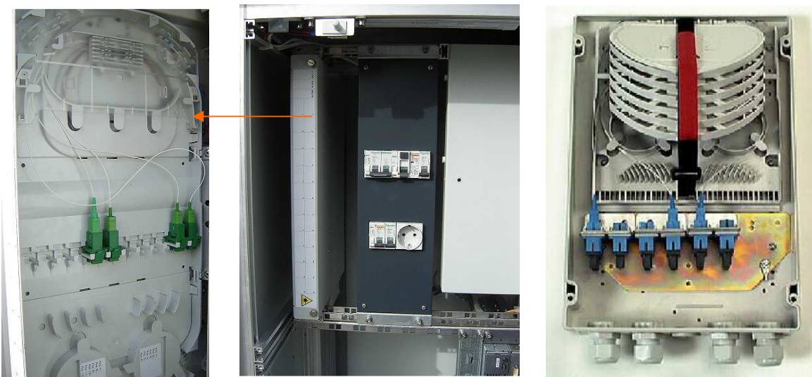
Σχήμα B2.4.4 Οπτικοί κατανεμητές στην καμπίνα Γ2 και σε εισαγωγές κτιρίων
