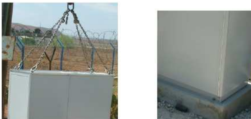
Σχήμα A.9.3.6 Τοποθέτηση καμπίνας
