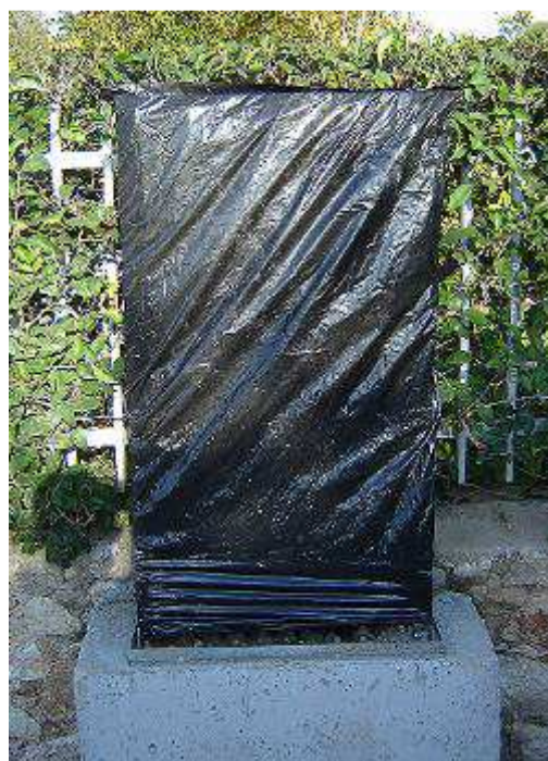
Σχήμα Α9.2.6 Προετοιμασία υφιστάμενου KV – Απομάκρυνση Μανδύα και Κάλυψη Κατανεμητή
