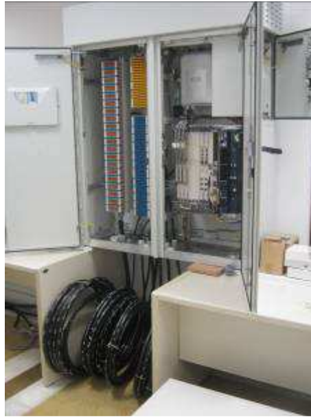
Σχήμα A9.2.20 Πλήρως προκαλωδιωμένη καμπίνα Γ3 πριν την εγκατάσταση
