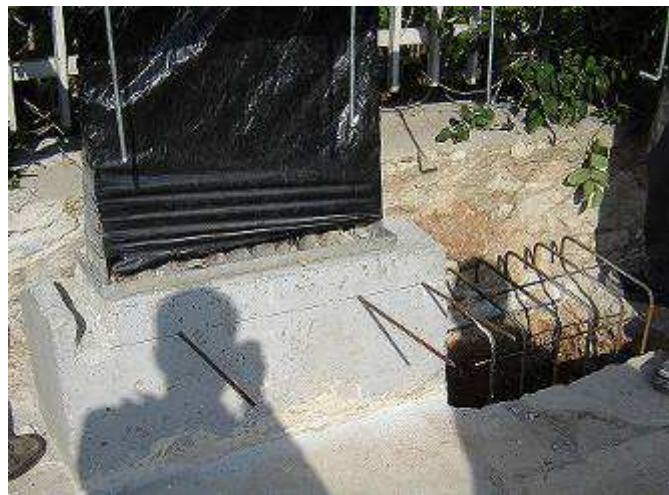
Σχήμα Α9.2.7 Προσαρμογή πλαισίου, εκσκαφή τάφρου επέκτασης, τοποθέτηση οπλισμού
