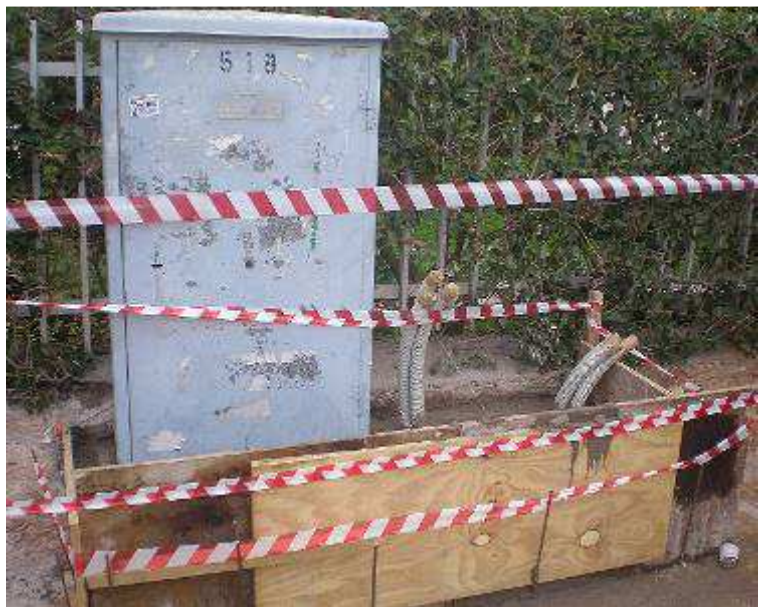
Σχήμα A9.2.9 Τοποθέτηση ξυλοτύπου, σκυροδέτηση και επανατοποθέτηση μανδύα KV
