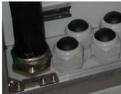
Σχήμα Α.9.1.10 Στυπιοθλίπτες στο εσωτερικό καμπίνας
