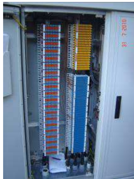
Σχήμα A9.2.19 Τοποθέτηση του κατανεμητή καλωδίων χαλκού στην καμπίνα Γ3 κατά και μετά την ολοκλήρωση των εργασιών τοποθέτησης
